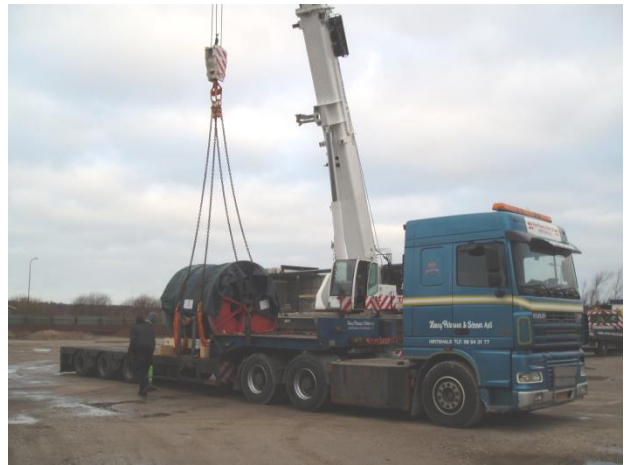
Aflæsning af kabel tromle
